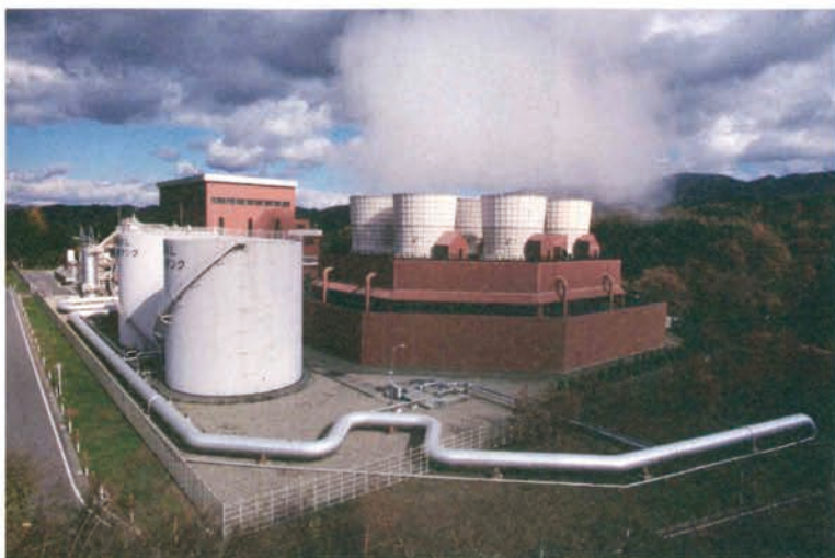
写真4 東北電力柳津西山地熱発電所。1995年に運転開始。単一の地熱発電ユニットとしては日本一の出力(2001年11月撮影)
